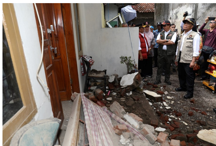
Gambar 18. Dampak Kerusakan Gempabumi M 4.8 di Sumedang
